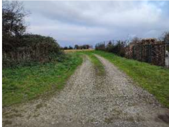
Photo n°1 – Un accès en attente d'aménagement
