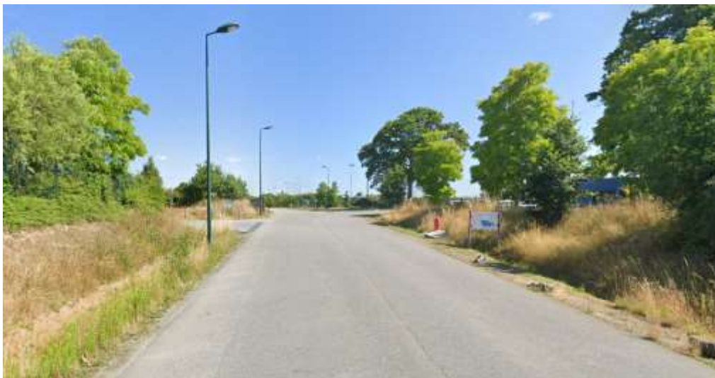
Photo n°1 – Un accès déjà aménagé
