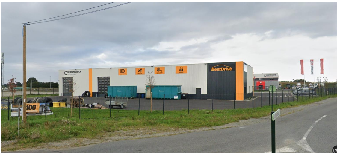
Ancienne plateforme LGV en cours d'aménagement
